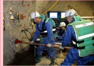
掘削影響評価試験 (140m水平坑道)
