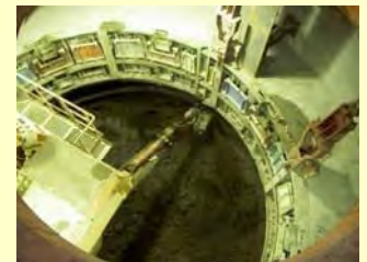
機械掘削の様子
