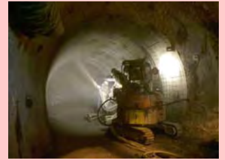
低アルカリ性セメントを用いたコンクリートによる吹付け施工 (140m水平坑道)
