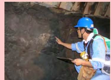
坑道壁面の観察
